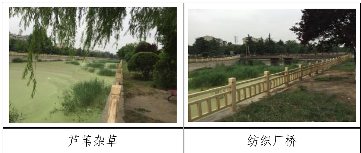
图 2-2 庆相桥至丁楼河段现状
